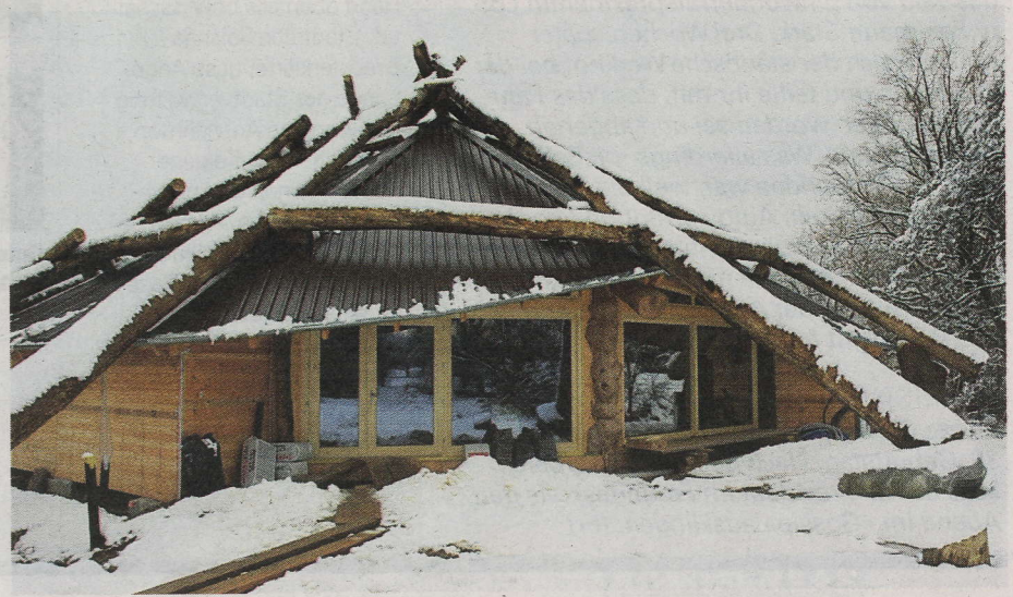
Die Arbeiten an der Aussenseite gehen wegen des strengen Winters harzig voran.
