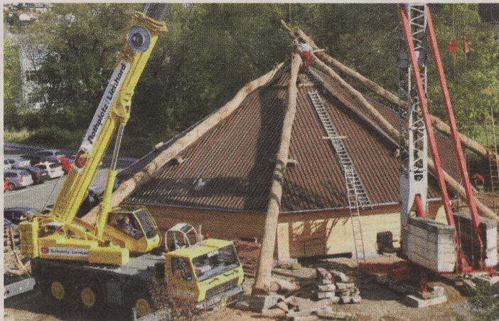
Die tonnenscheren Eichenstämmen der Biberburg werden mit dem Kran millimetergenau platziert.
