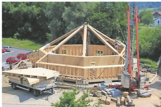
Die «Biberburg» im Bau, 2008.
